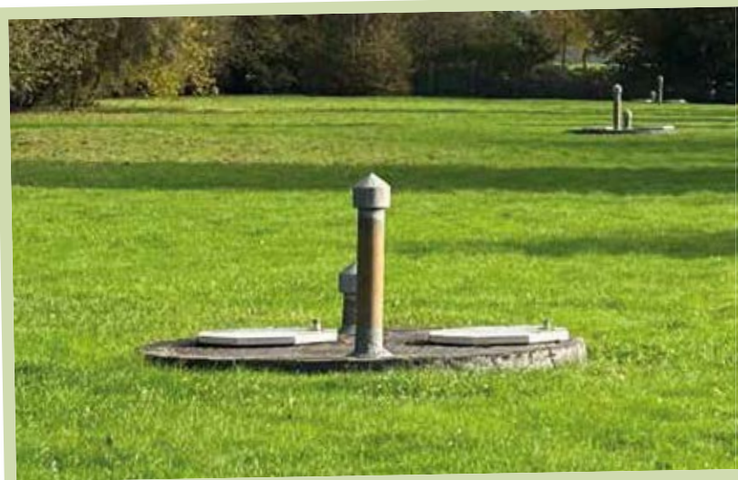
Eine der Brunnengalerien der Stadtwerke Troisdorf: Hier im Eschmarer Trinkwasserschutzgebiet wird das Grundwasser gefördert und zur Aufbereitung ins Wasserwerk geleitet.
